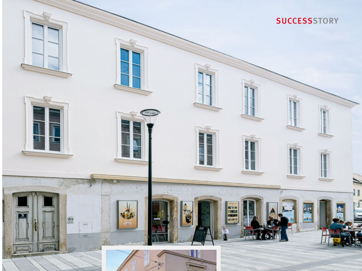
Wenige Profile waren noch erhalten, der Rest wurde originalgetreu nachgebaut. Die Seite zur Domgasse hin hat der Eigentümer auf eigene Initiative ergänzt.
