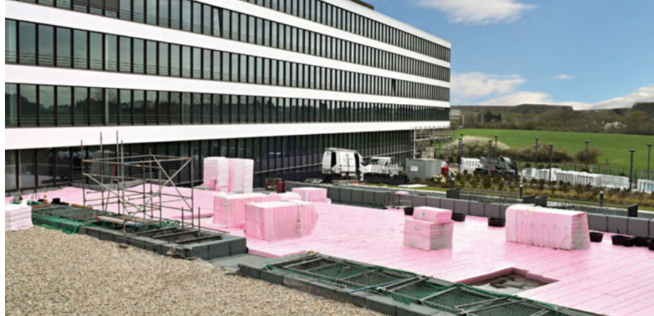
Um notwendige Anschlusshöhen herzustellen beziehungsweise zu vergrößern, wurden die Platten je nach Bereich in unterschiedlichen Dicken verlegt. Im vorderen Bereich sind die Austrotherm Dämmplatten bereits mit einer Kiesschicht belegt.
