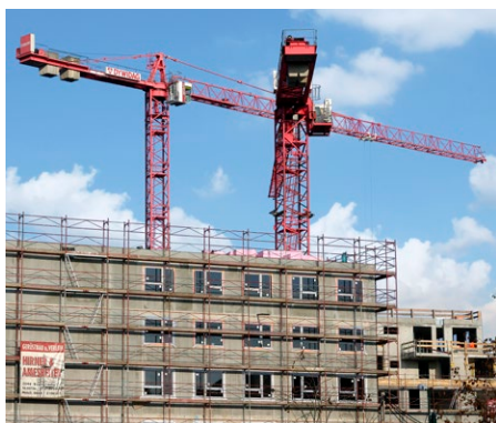
Foto: Stadtoase Tulln Errichtungs GmbH / Diamond City Hotel
