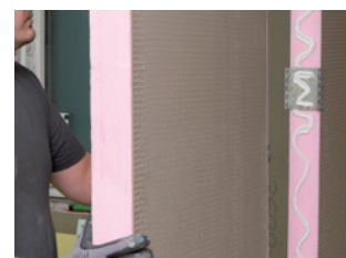
4. Allerede en Austrotherm UNI plade kan bli slått sammen med den andre.
