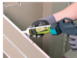
2. Trekk kantene på brettet med Murexin Special Adhesive X-Bond MS-K88 Express.
