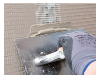
6. Sett glassilke stoffet, fyll bare med limmørtel - overflaten er klar!
