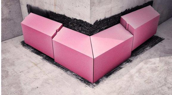
Z-Foliendämmung im zweischaligen Mauerwerk aus Extruderschaum mit **stirnseitiger Nut & Feder**
