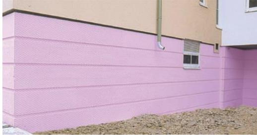
Druckfeste Wärmedämmplatte aus extrudiertem Polystyrolhartschaum mit **geprägter Oberfläche**.
