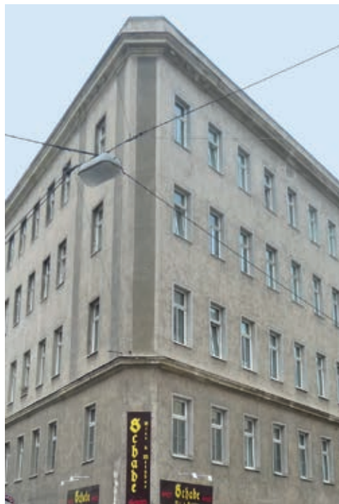
2012: Das Haus ohne Fassadenprofile
