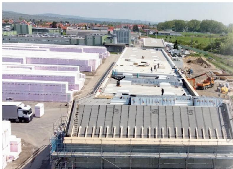
Am Dach wurde das besser dämmende graue Austrotherm EPS® W25-PLUS, teils als Gefälledach, mit einer Dämmdicke bis zu 26 cm verbaut.
