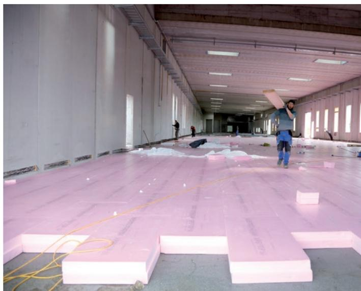
Das hochbelastbare Austrotherm XPS® TOP 50 dämmt den Boden der neuen Produktionshalle. Die Fußbodenheizung wird mittels Bauteilaktivierung energiesparend durch die Abwärme der Produktionsanlagen betrieben.
