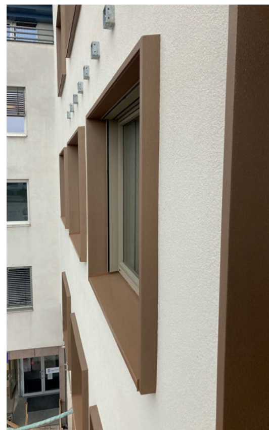
Das Austrotherm Architekturelement im Fensteranschluss führt zu einer Monitoroptik.
