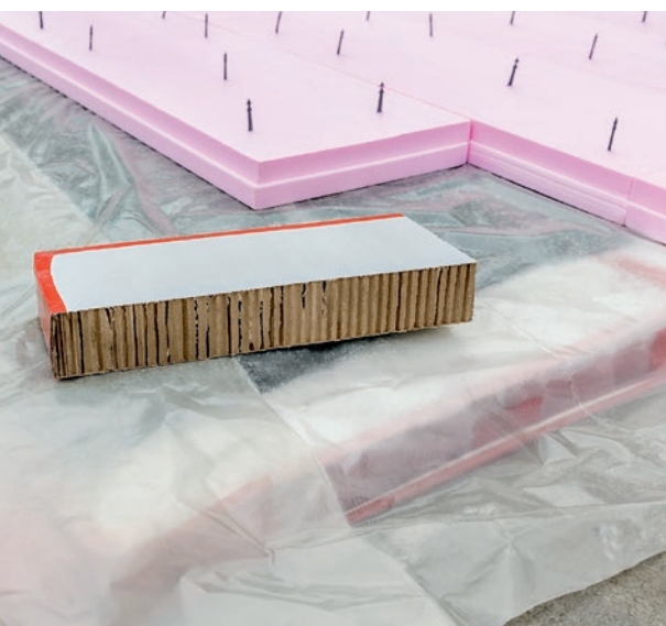
Die speziellen Papierwabenplatten zersetzen sich bei kontrollierter Wasserbeaufschlagung. So entsteht ein Hohlraum. Bodenplatte und Dämmung sind dann freischwingend.
