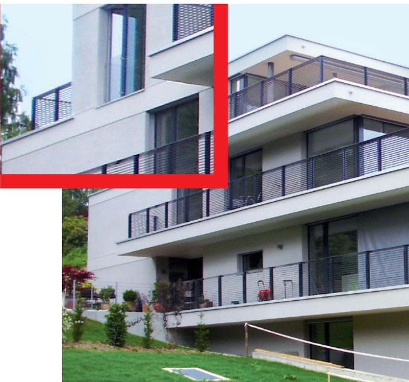
Beim Terrassenhaus in Wermatswil wurden die Fassadenprofile auf dem Mauerwerk verklebt und flächenbündig mit dem Wärmedämmverbund-System verbunden.
