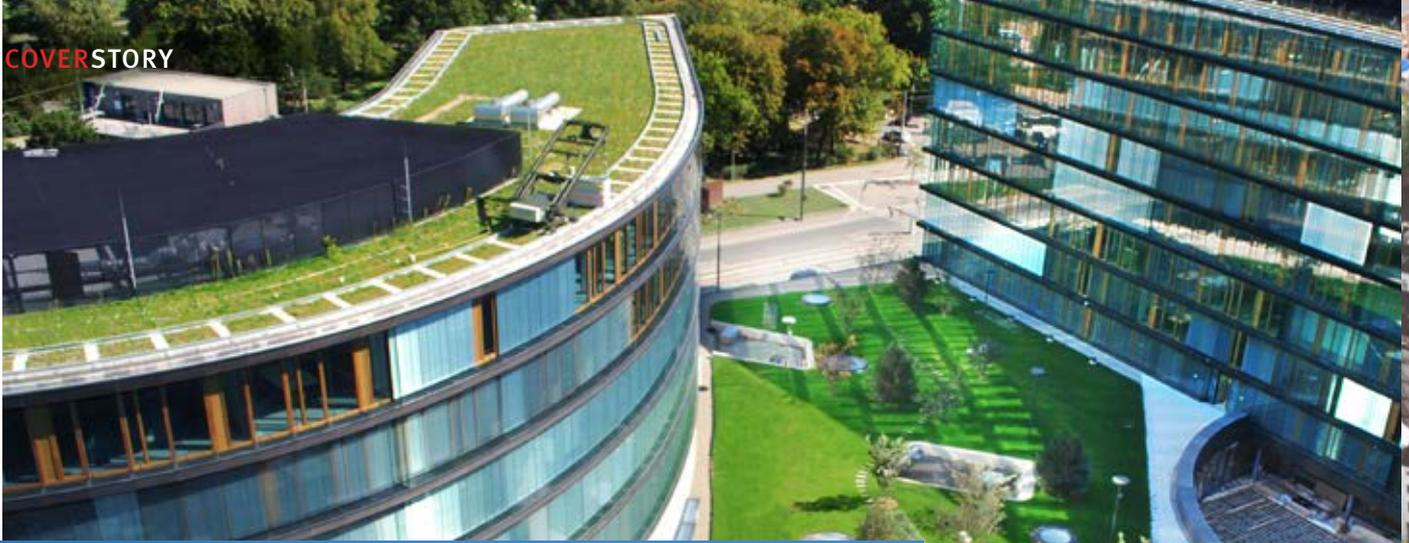
„In der Wartungsintensität besteht beim extensiv bepflanzten Gründach kein Unterschied zum Kiesdach.“
