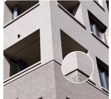
Austrotherm Gurtgesimse sowie glatter und rauher Putz
