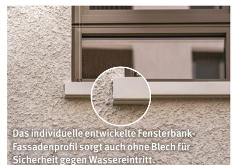
Das individuell entwickelte Fensterbank-Fassadenprofil sorgt auch ohne Blech für Sicherheit gegen Wassereintritt.
