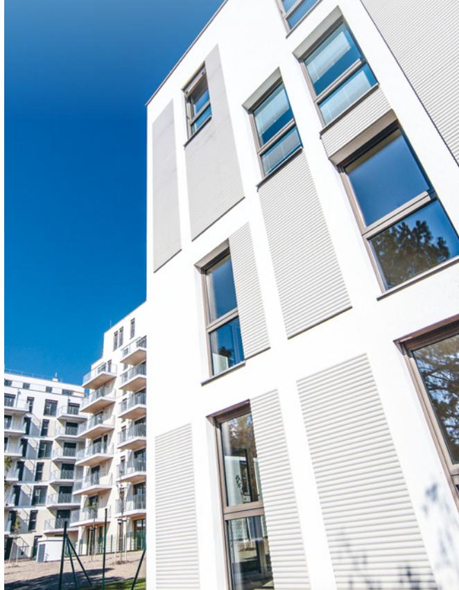
Mit Austrotherm Fassadenprofilen wie der Wellenfassade können einfach moderne profilierte Fassaden geschaffen werden.
