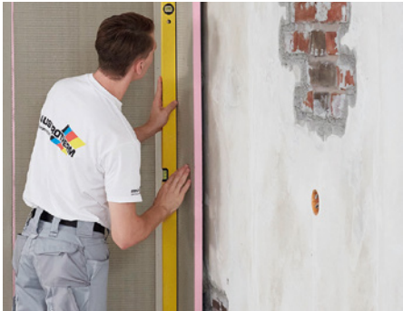
Wandverkleidung Altbauwand
