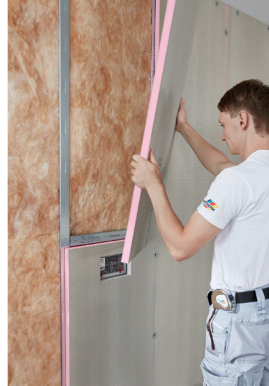
Wandverkleidung Ständerwerk
