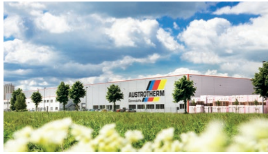
Austrotherm Deutschland Zentrale und Werk Wittenberge
