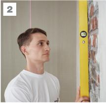
Lotrechte prüfen und ausmessen Lotrechte Ebenheit prüfen, Wandhöhe ausmessen und die Maße auf die Platte übertragen. Die Austrotherm UNIPLATTEN haben eine Länge von 130 Zentimetern bzw. 260 Zentimetern.
