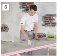
Kleben vorbereiten Austrotherm UNIPLATTEN werden geklebt und zusätzlich mechanisch befestigt. Zunächst Mörtelbatzen über die vorgebohrten Löcher aufbringen.
