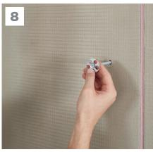
Mechanisch befestigen – Teil 2 Mit geeigneten Dämmstofftellern und einem Akkuschrauber die Austrotherm UNIPLATTEN an der Wand befestigen.
