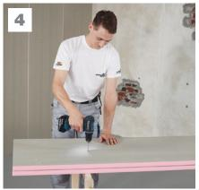
Befestigungspunkte vorbohren Zunächst die Löcher für die Dämmstoffteller vorbohren. Zu rechnen sind mit acht bis zwölf Befestigungspunkten bei einer 260 Zentimeter langen Platte.
