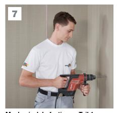
Mechanisch befestigen – Teil 1 Die vorgebohrten Löcher für die mechanische Befestigung durch die getrockneten Mörtelbatzen bis in die Wand hinein bohren.
