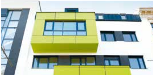
Fassadendämmplatte mit Austrotherm Beschichtungsmasse TOP.
