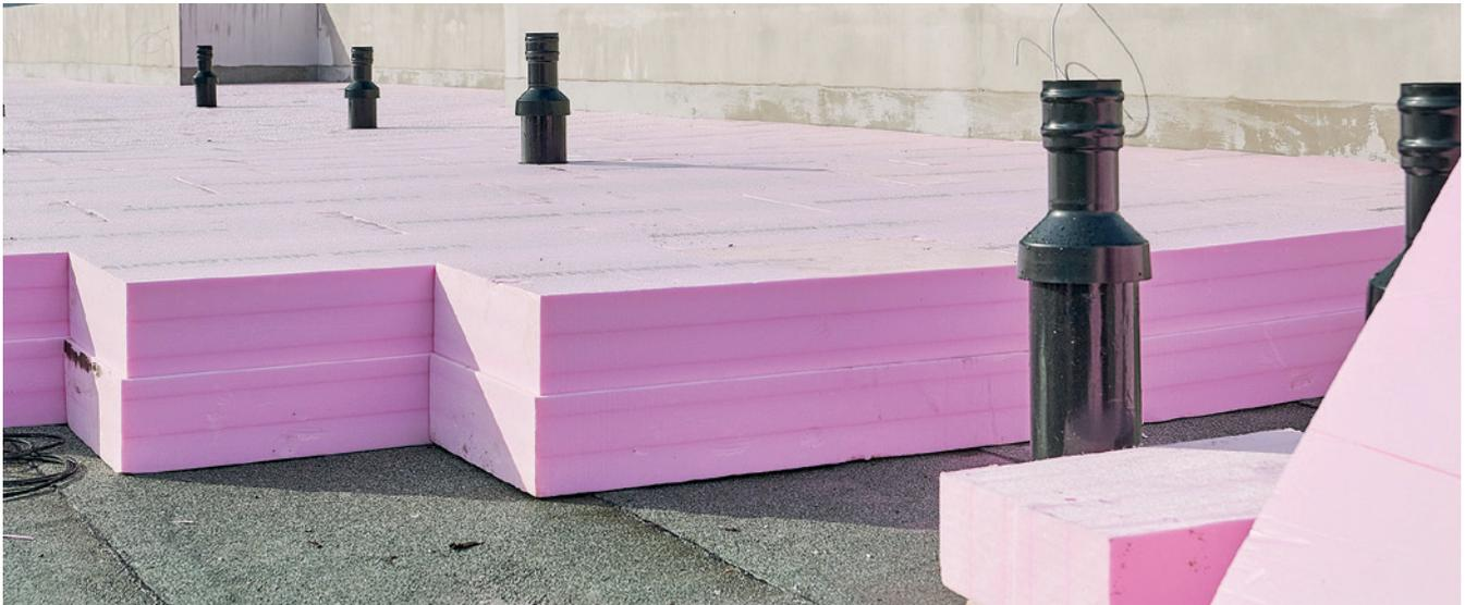
Ob im Umkehrdach, im Perimeterbereich, an der Fassade oder am Sockel, die Austrotherm XPS® Dämmplatten halten den unterschiedlichsten Belastungen stand. Unempfindlichkeit gegen Feuchtigkeit, Frost-Tau-Wechselbeständigkeit, mechanische Festigkeit, Verrottungs- sowie Wurzelfestigkeit sind nur einige der guten Eigenschaften dieses Alleskönners.
