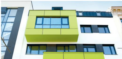
Fassadendämmplatte mit Austrotherm Beschichtungsmasse TOP.
