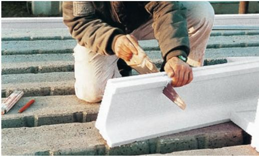
Vorgefertigtes Schalungselement mit bester Wärmebrückendämmung. Rasche Verarbeitung durch einfache Verklebung auf das Mauerwerk.
