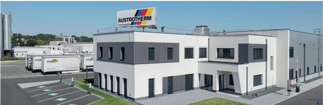
Ein Klimaschutz-Projekt, das zur Nachahmung einladen soll, ist das neue Plusenergie-Bürogebäude am Austrotherm Werksgelände in Pinkafeld. Im Herbst 2021 ging das Gebäude in Betrieb und produziert seither mehr Energie, als es verbraucht. Möglich machen das die hocheffizienten Austrotherm Dämmstoffe, die vom Untergrund über die Fassade bis zum Dach eingesetzt werden, sowie eine
