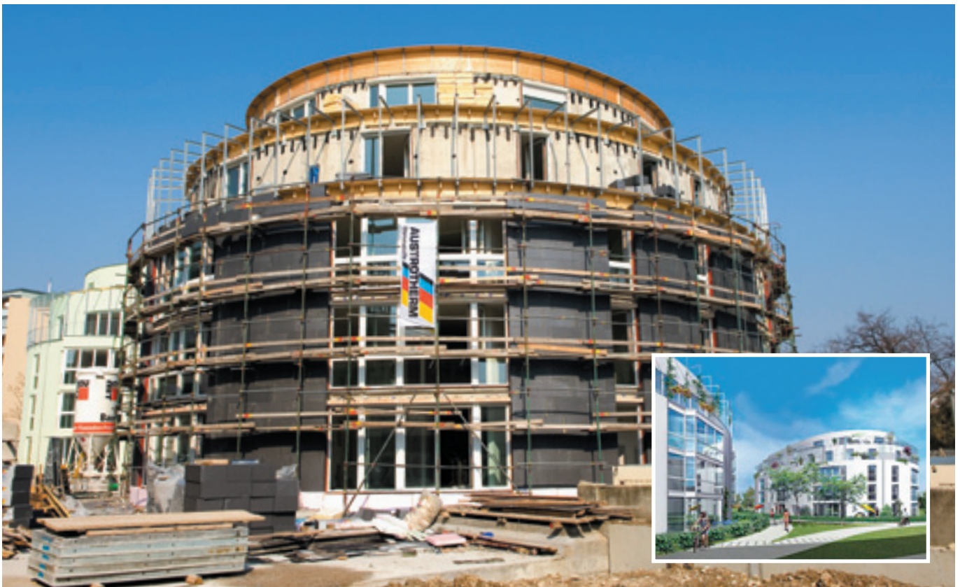
Mit 30 cm dickem Austrotherm EPS® F-PLUS gedämmt: die Passivhaus-Melone des Projektes „Energiesparendes Wohnen im Obstgarten“.
