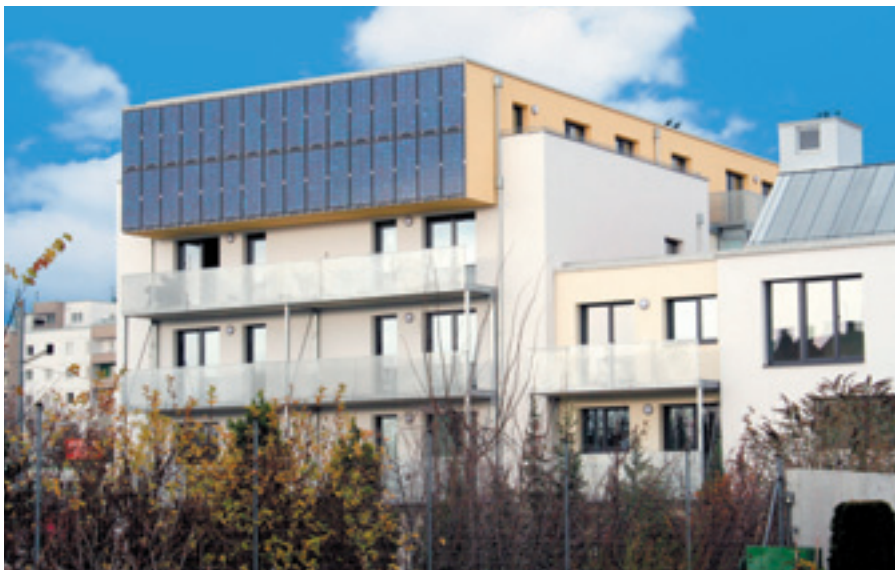
Perfekter Komfort für 114 Wohneinheiten: die Passivhauswohnanlage Pantucekgasse in Wien-Simmering
