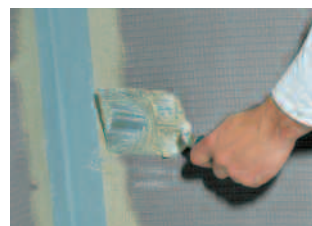
Poser enfin la bande d'étanchéité, avant de lisser simplement avec l'enduit de lissage mural - le support terminé est lisse !
