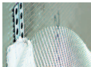
Les joints de panneau sont obturés avec des bandes de tissu de soie de verre.
