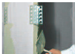
L'agrafe de raccordement Murexin est également montée rapidement.
