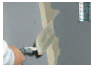
Le panneau Austrotherm UNIPLATTE® peut être monté immédiatement. L'angle droit est ainsi garanti.
