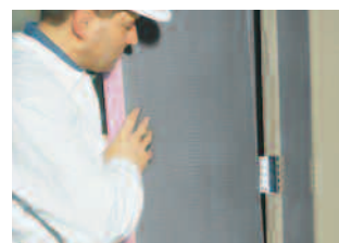
Un panneau Austrotherm UNIPLATTE® vient déjà s'assembler au premier.
